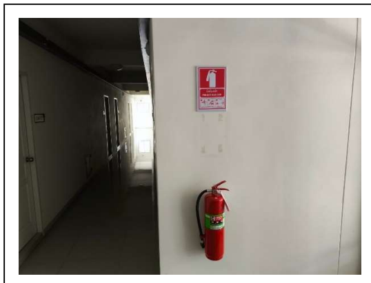
รูปที่ 2.1-30 ติดตั้งเครื่องดับเพลิงแบบมือถือ เป็นเครื่อง ดับเพลิงเคมีความจุ 15 ปอนด์
